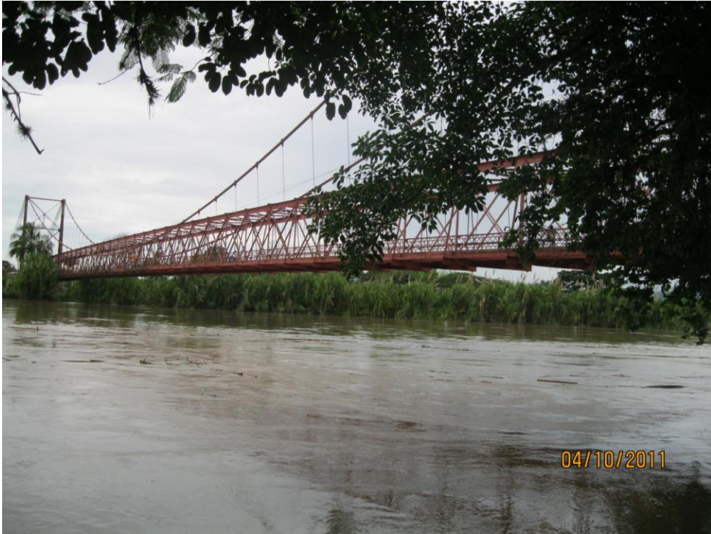
Puente Bernardo Arango. Fuente: Bomberos Voluntarios La Virginia Risaralda.
