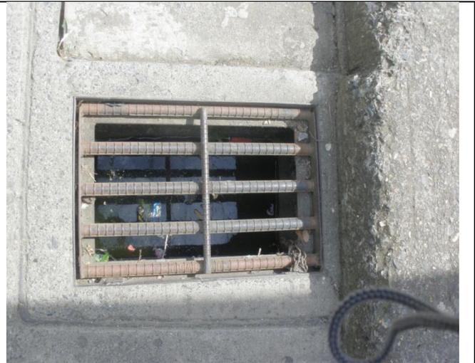
**Foto 4: Mal estado de las alcantarillas**
